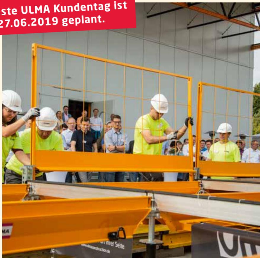
Weltneuheit CC-4 Protect: Das Deckenschalungssystem wurde um eine Fallschutz und Seitenschutzlösung erweitert, die ein sicheres Arbeiten von oben ohne Persönliche Schutzausrüstung ermöglicht.
