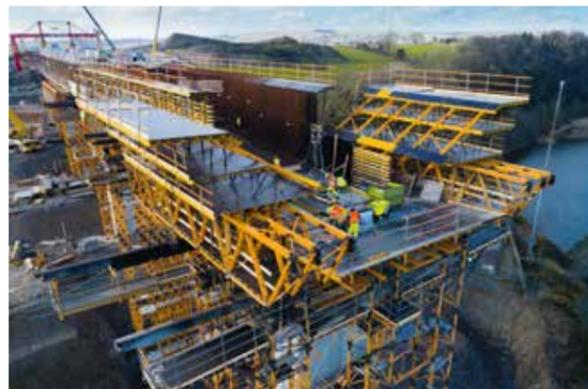
Als Schalung für die Pfeiler kam das ENKOFORM V-100-System zum Einsatz, in Kombination mit einer CR-250-Kletterschalung. Foto: ULMA Construction GmbH
