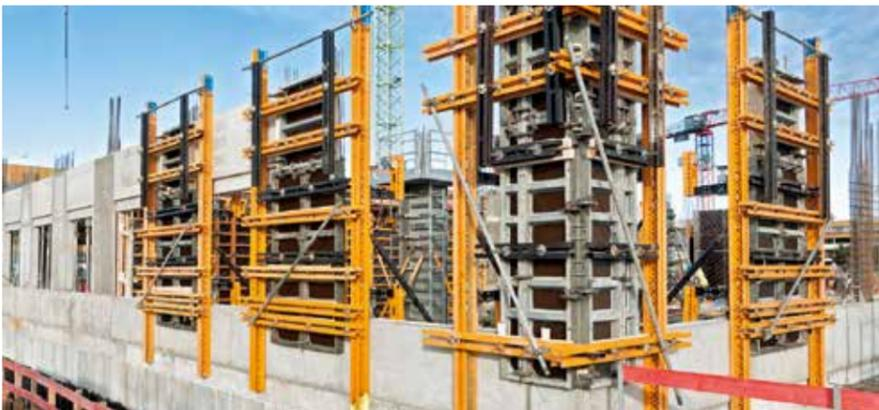
Ein besonderes Highlight im Rahmen der Erweiterung des Campeon war der Einsatz der Fassadenschalung MK, die in dieser Form erstmals in Deutschland Verwendung fand. Durch den Einsatz des Systems konnte auf die Errichtung eines zusätzlichen Arbeits- und Schutzgerüsts komplett verzichtet werden.
