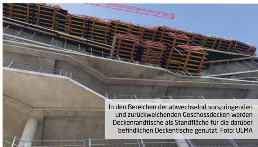
In den Bereichen der abwechselnd vorspringenden und zurückweichenden Geschossdecken werden Deckenrandtische als Standfläche für die darüber befindlichen Deckentische genutzt. Foto: ULMA
