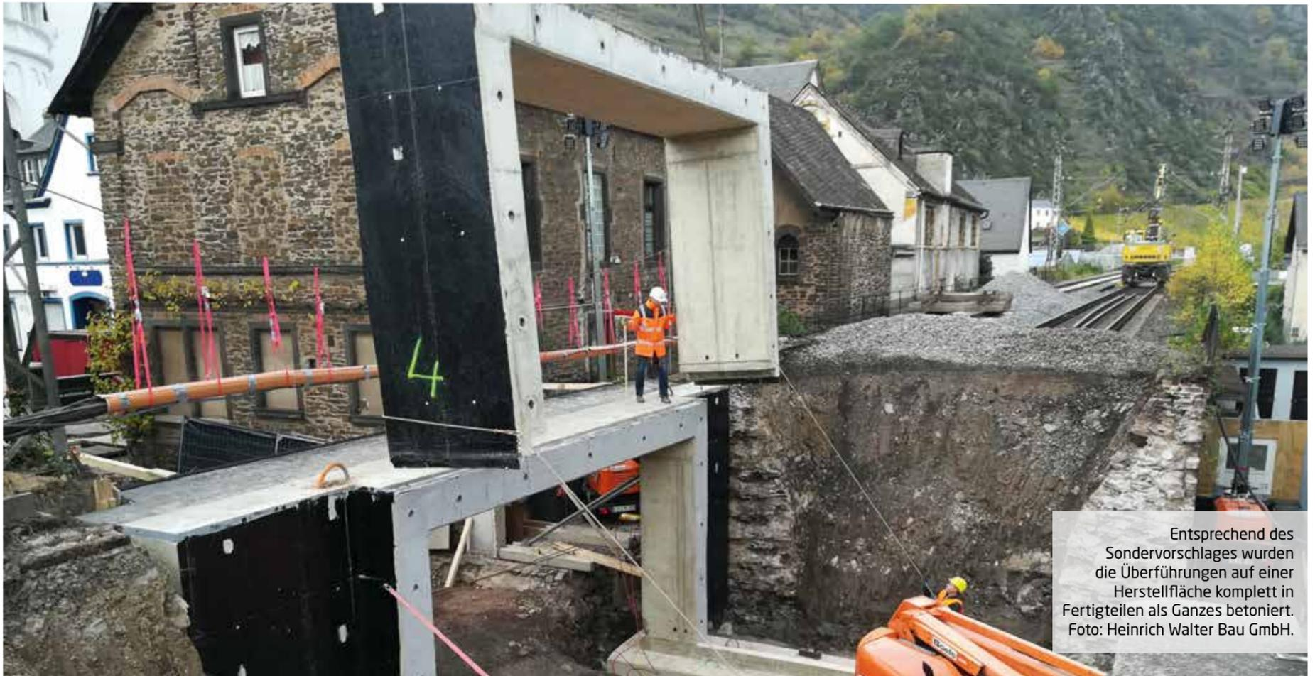
Entsprechend des Sondervorschlages wurden die Überführungen auf einer Herstellfläche komplett in Fertigteilen als Ganzes betoniert. Foto: Heinrich Walter Bau GmbH.
