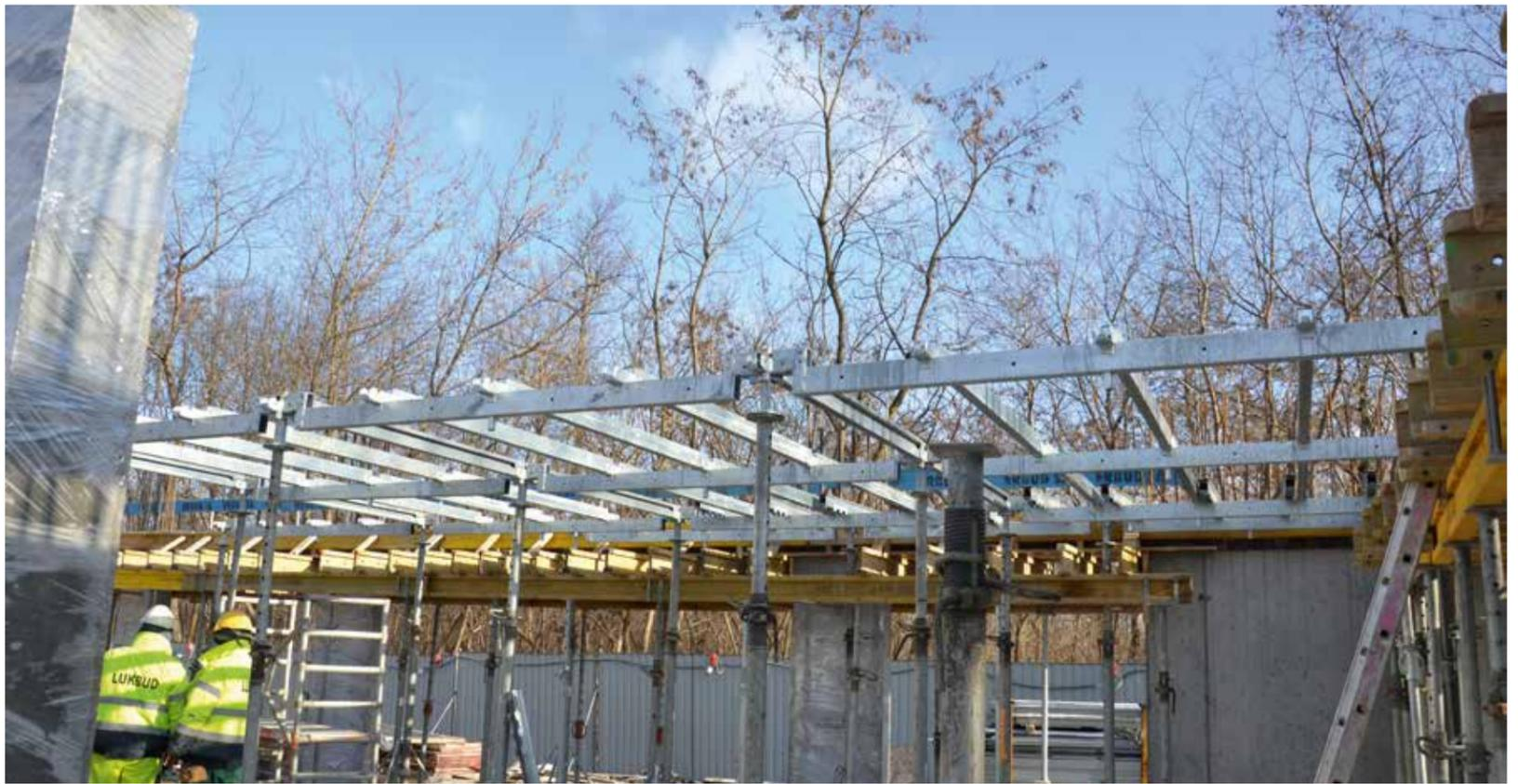
ONADEK besteht aus nur sechs Systemteilen: Stütze, Fallkopf, Querträger, Belagträger, Hauptträger und Belag mit Passstreifen.
